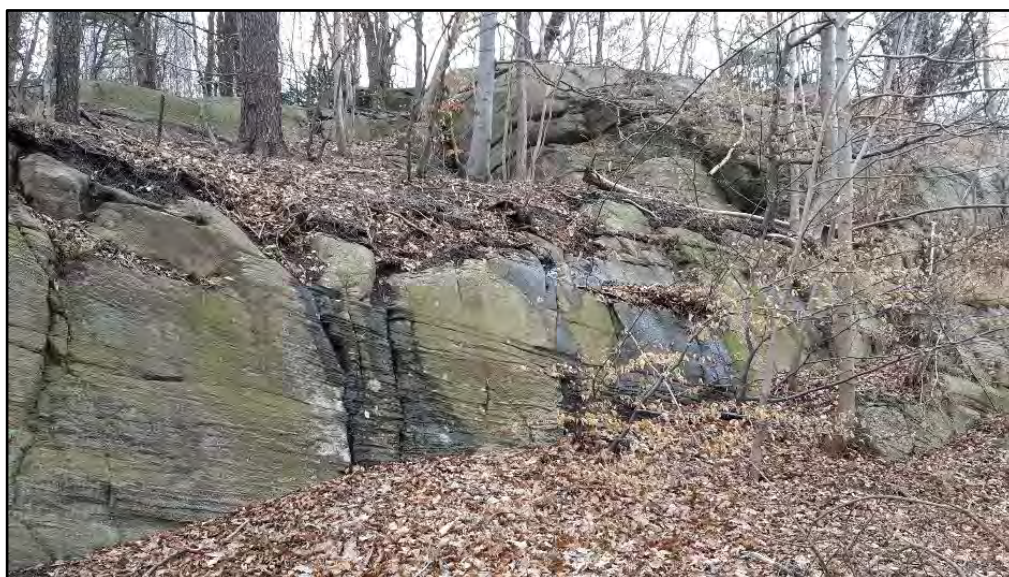
Figur 3. Berghäll i område 1 med frekventa sprickor.
